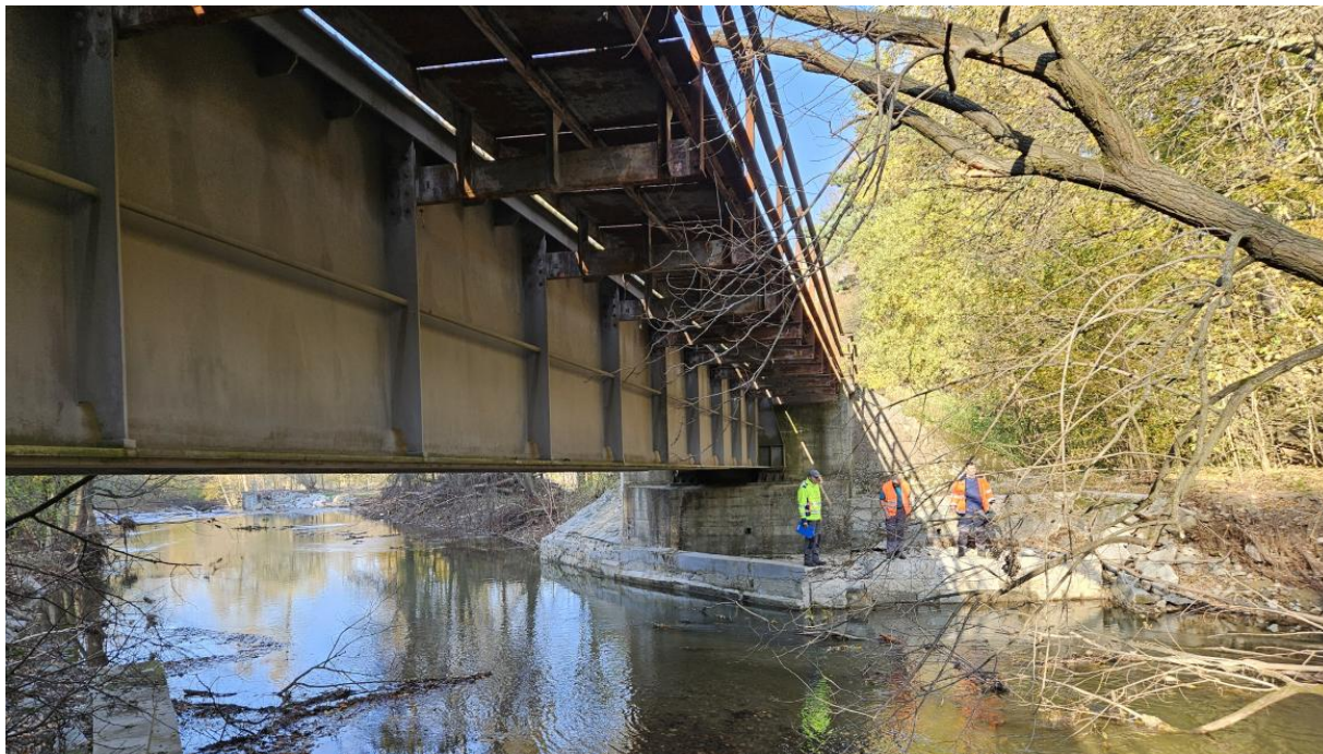
Obrázek 1. Celkový pohled na most a opěru O2, na pravé straně O2 je viditelná poškozená zídka
